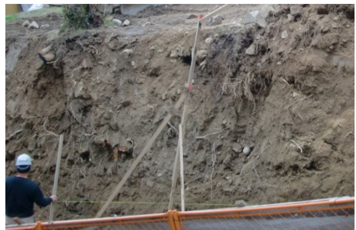
写真：背面の状況
