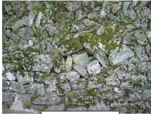
石垣積替部拡大
