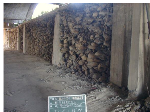
↑写真 18 内壁解体後
