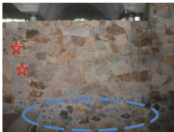
↑ 写真7 石材調査の管理状況（内部）
