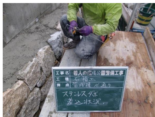
↑写真25 ステンレス引き金物の施工状況
