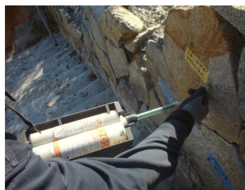
↑ 写真 23 樹脂注入状況
