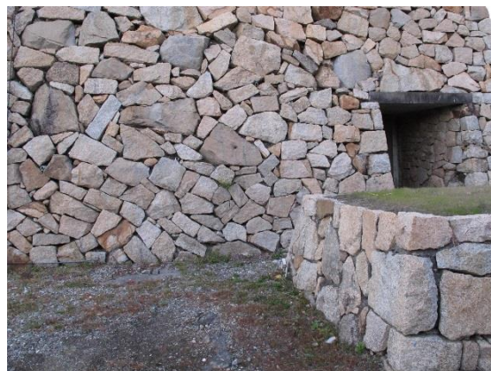
↑ 写真 1 石積みの外観
