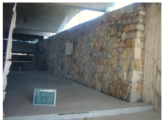
↑写真 17 内壁解体前
