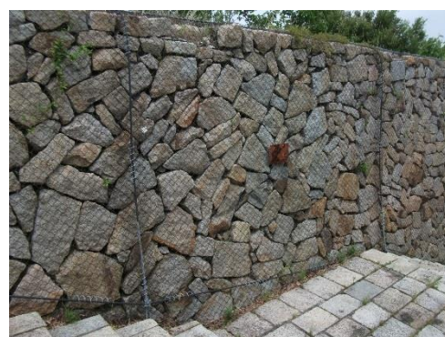
↑写真10 通路側の石積みの状況
