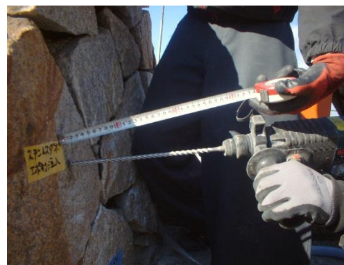
↑ 写真 22 石材削孔状況
