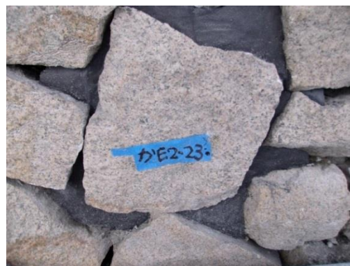
↑ 写真 24 目地補修
