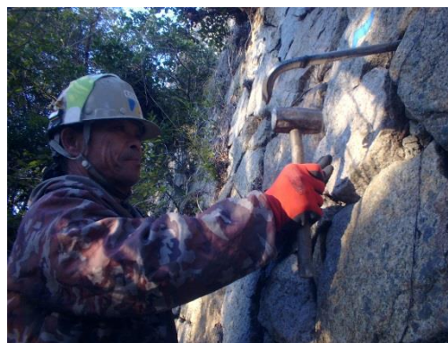
↑写真 20 浮き調査状況
