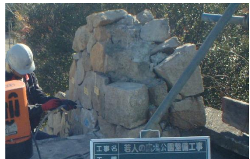
↑写真 16 屋上パラペット石積基礎
