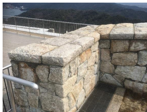
↑写真26 新設笠石の状況
