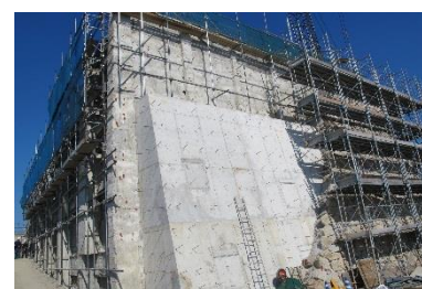
工事中の躯体
