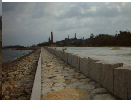
図 8 海岸の石張りと防潮堤
