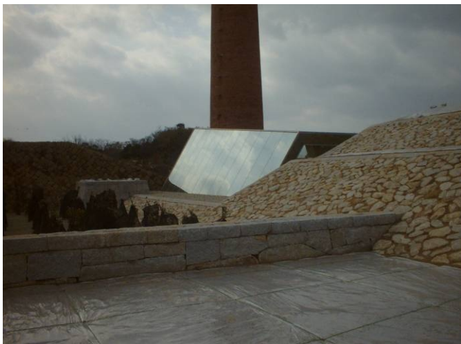
図 7 野面石で覆われた壁面
