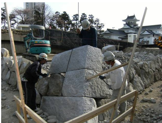
図13 角石積み状況
