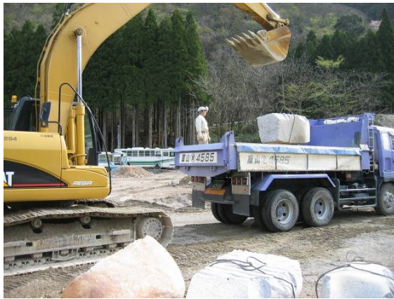
図7 石材運搬状況(早月川)
