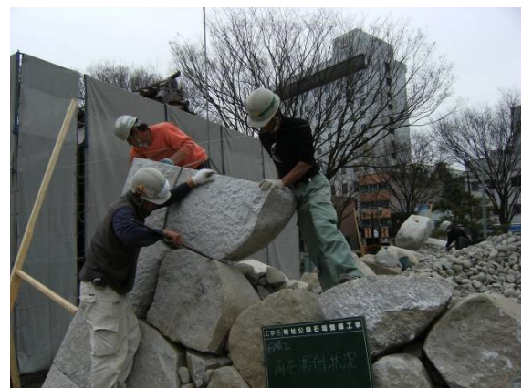
図14 角石積み状況
