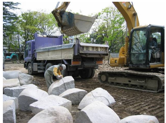
図8 石材搬入状況(城址公園)
