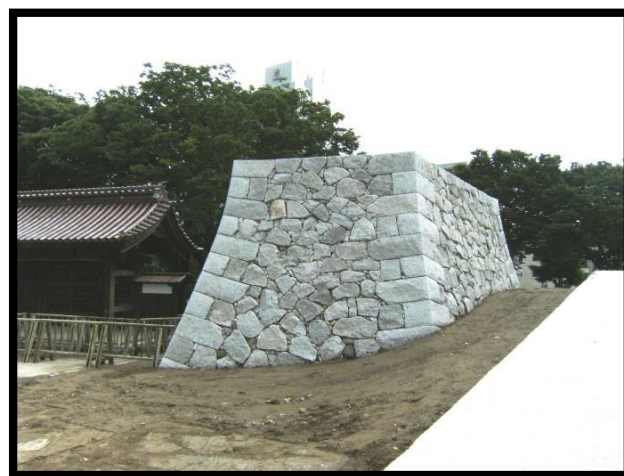
図22 完成(南西面) (左奥は千歳御門)
