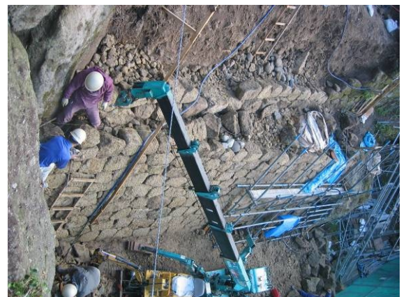
石積み作業状況
