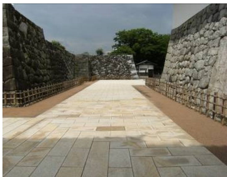
板石敷き (将来の再利用に耐える厚みを 80mm / m)
