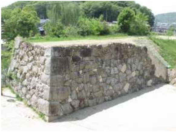
左中：姫路城清水門石垣修理
