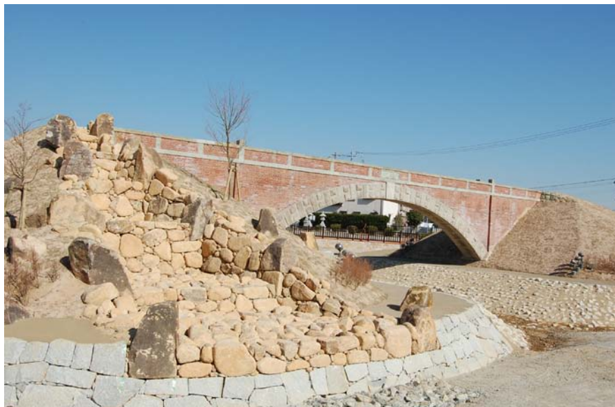
□ 赤穂石での滝組 平木橋解体復元（大正4年築）兵庫県加古川市 石造+煉瓦のアーチ橋
