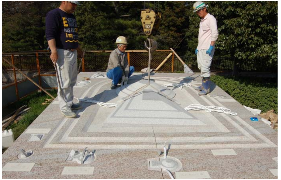
堺灯台解体復元
