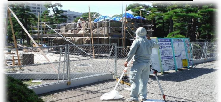
石垣の高さ・位置などを測量により確認しています
