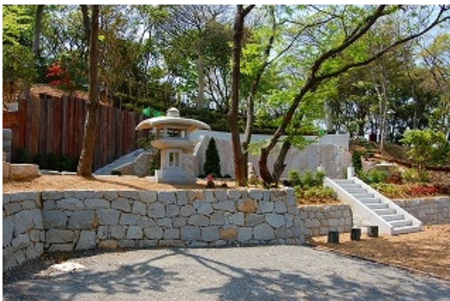
野面積施工例
